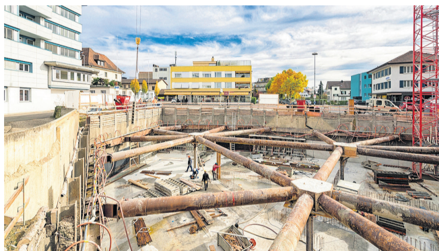
Eine der grössten Herausforderungen war der Aushub auf engstem Raum. Sogenannte innere Spriessungen wurden deshalb beim Baustart benötigt.
