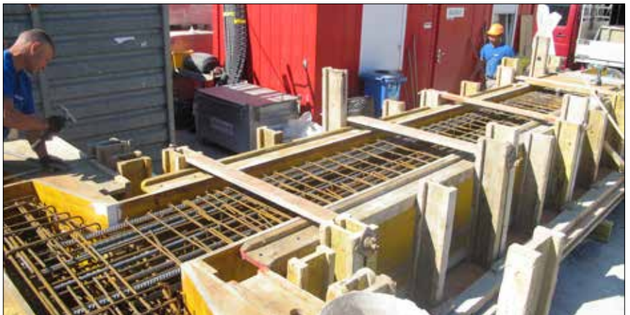
Digitec Galaxus AG Passerelle: Elementstütze vorfabrizieren auf Baustelle
