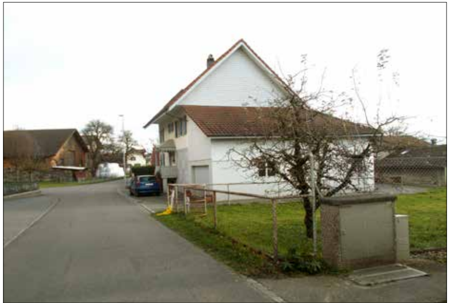
Einfamilienhaus Dorfstrasse 5 (vorher)
