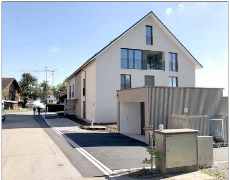
Mehrfamilienhaus Dorfstrasse 5 (nachher)
