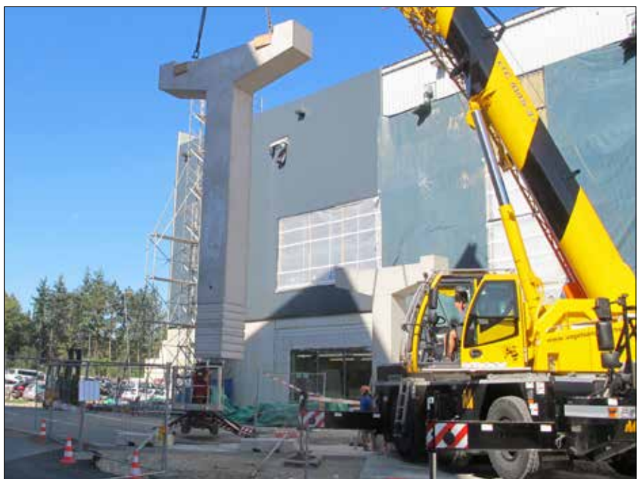
... und Montage der Stützen
