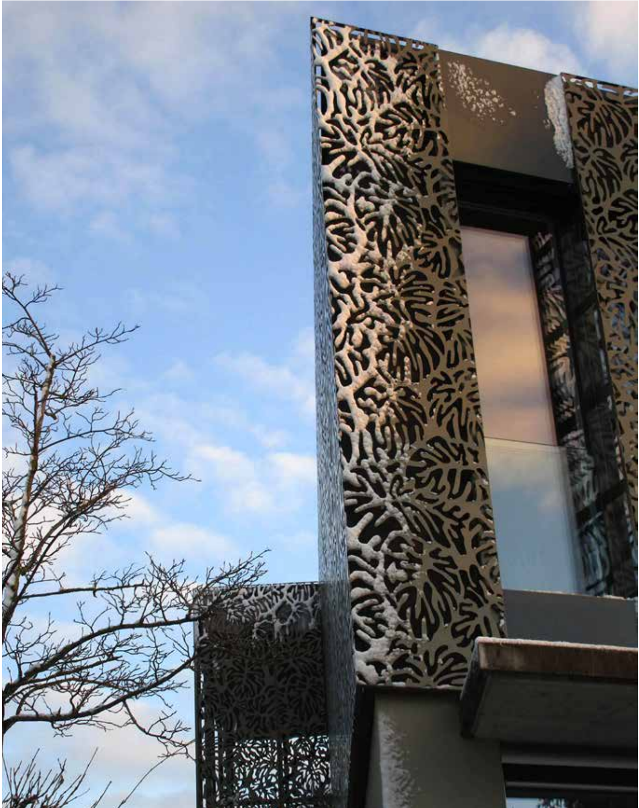
Fassadenbild: Gebäudeaufstockung Bestattungsinstitut, Wohlen
