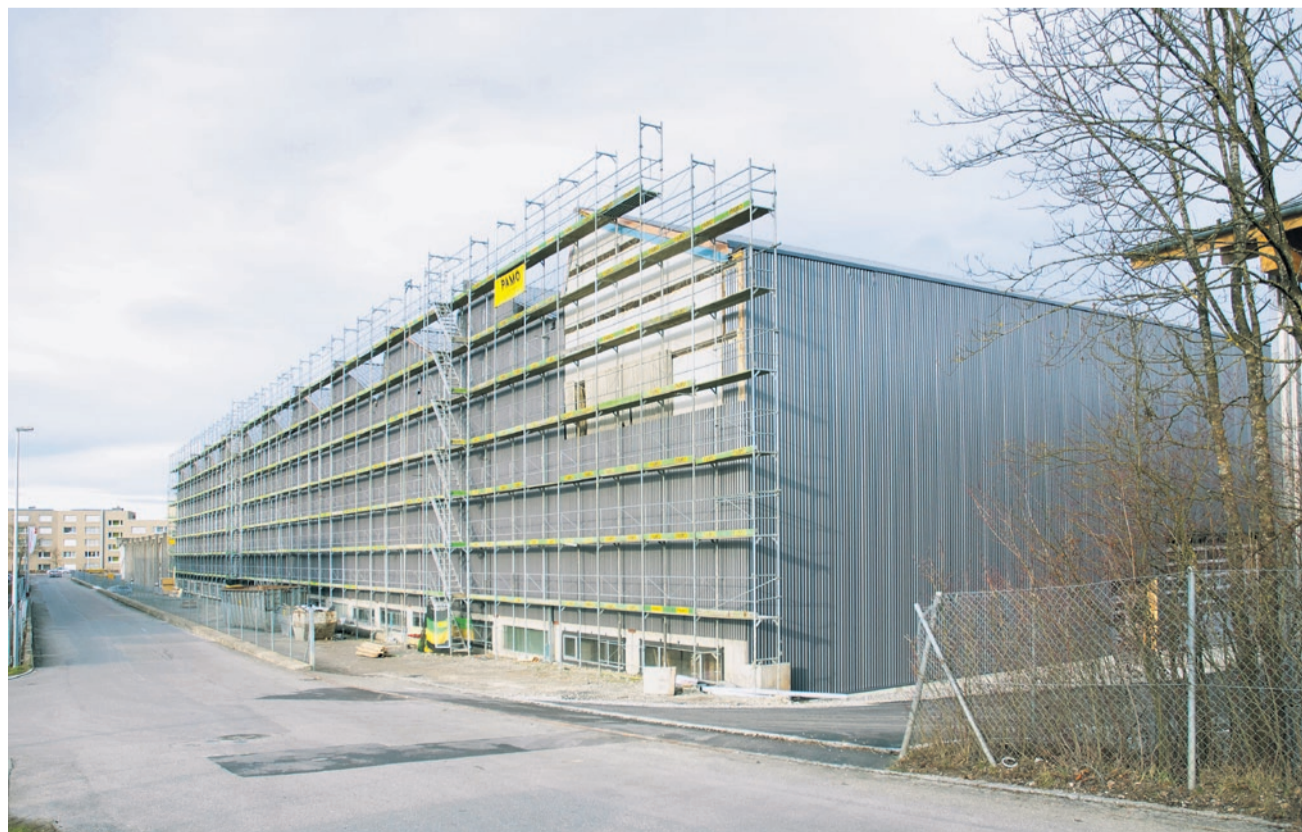
Neuer Werkhof im Bau (aus Sicht Schützenstrasse).
