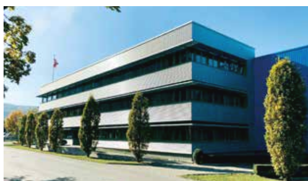
Bürohaus und Produktionsgebäude, Villmergen 2005
