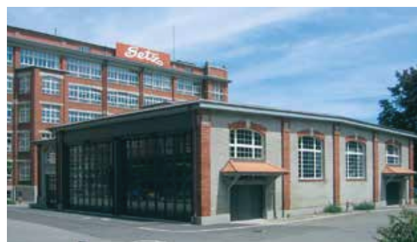
Kesselhaus und Gewerbecenter, Dottikon 2005
